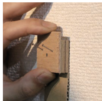
予め木製フックの 2 箇所の小さい穴に細クギを斜めに差し込んでおく
