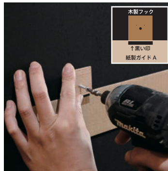
紙製ガイドの黒い印の部分に木製フックをあわせて木ネジで取付けます
