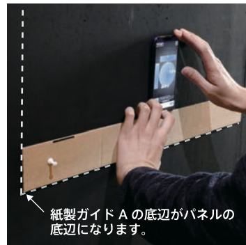
紙製ガイド A が水平になるように同梱のピンで留めます（写真はアプリ使用）
